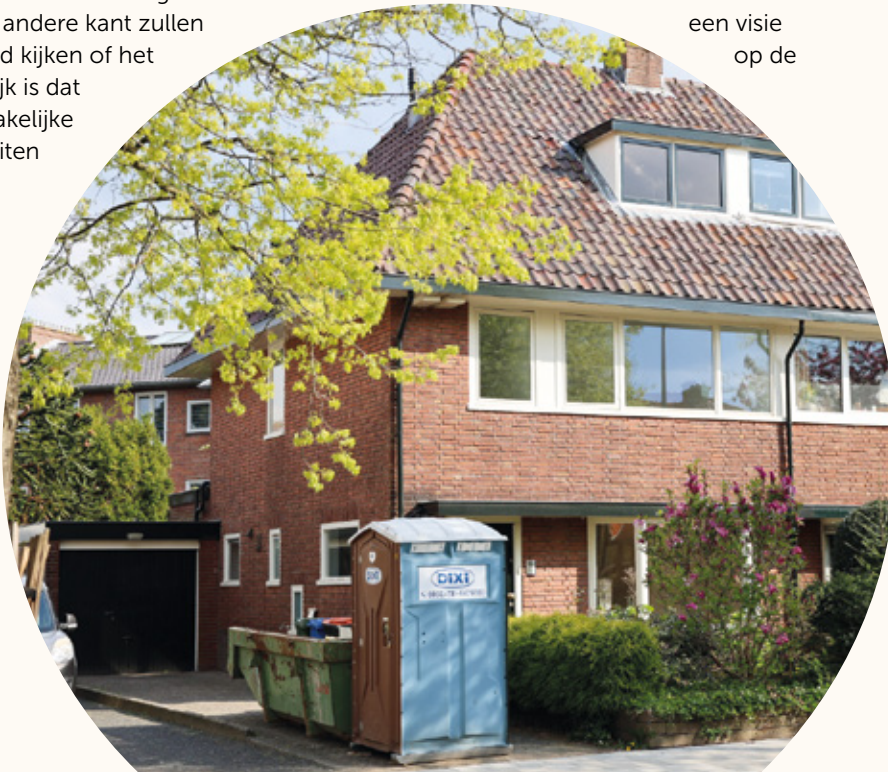
De renovatie van de woning voor dominee Van Dam (Joriskerk) staat op het punt om te beginnen.
